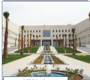
مبنى وزارة التعليم
