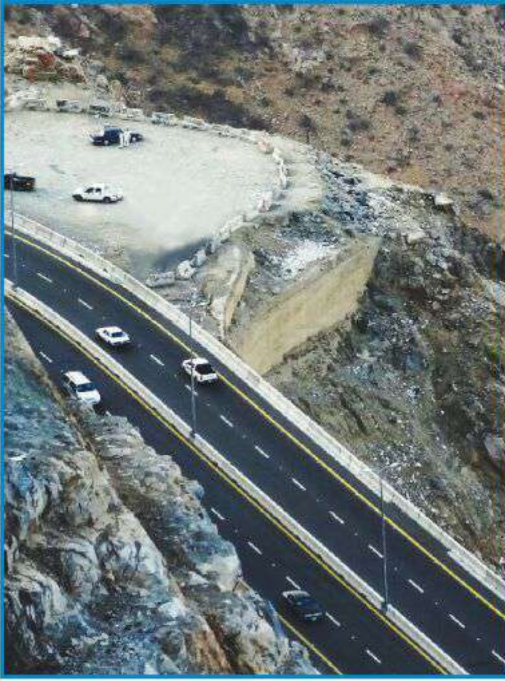
هذا الطريق سطح مائل
