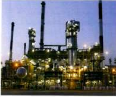
محطة توليد الكهرباء في الجبل
