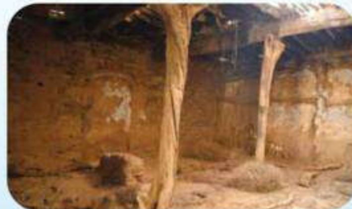
مسجد تاريخي قبل ترميمه
