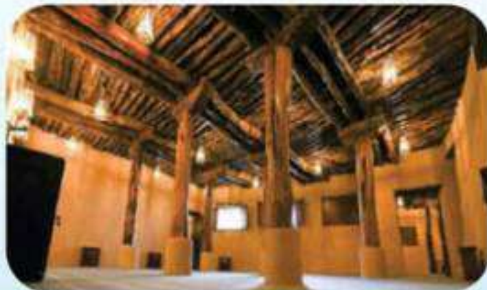
مسجد تاريخي بعد ترميمه
