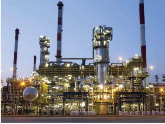
محطة توليد الكهرباء في الجبيل
