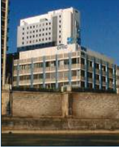
مبنى منظمة أوبك في فيينا
